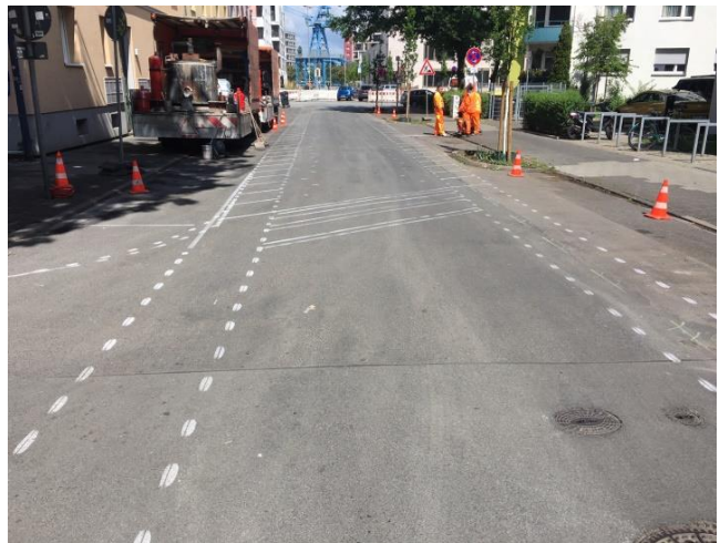
Markierungsarbeiten Taunusstraße - Einrichtung einer Fahrradstraße
