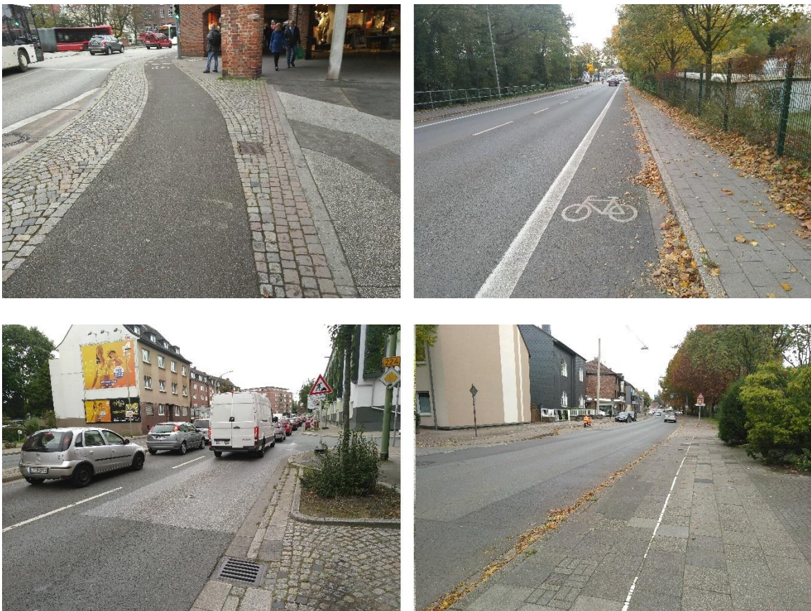
Abbildung 9: Beispiele für Oberflächenzustände (oben: sehr gut, unten: mittelmäßig) (Eigene Aufnahmen)
