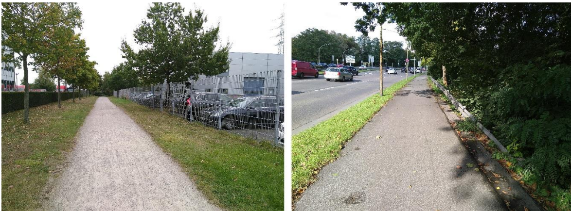
Abbildung 5: Beispiele für separate Radwege, die eigenständig (links) oder durch eine physische Barriere getrennt von der Kfz-Fahrbahn verlaufen (rechts) (Eigene Aufnahmen)
