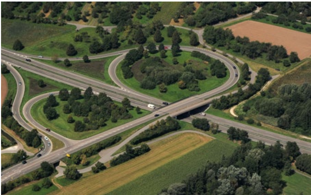
Abbildung 1: Die Ausfahrt Schorndorf-West der Bundesstraße 29 von oben.
